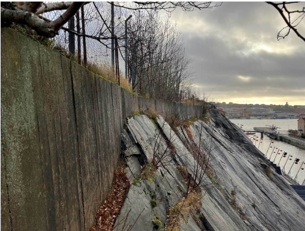
Figur 3. Bild på del av västra stödmuren, tagen mot söder.
